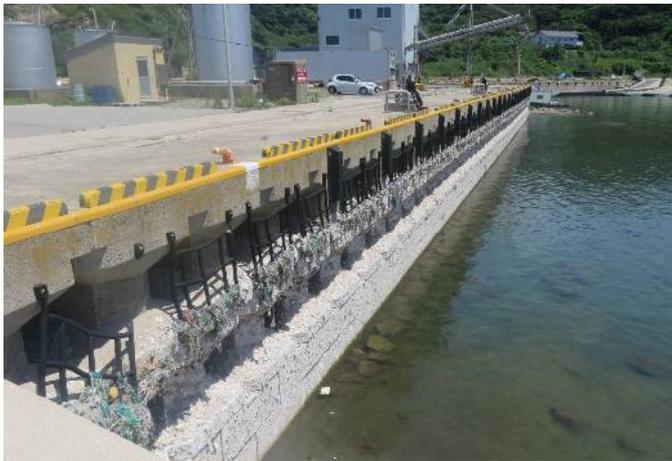
漁船を係留する栈橋も、鉄筋が露出し、更に漁港の海底が完全に見えてしまっていました。とても漁船を横付けできる状態ではありません。
