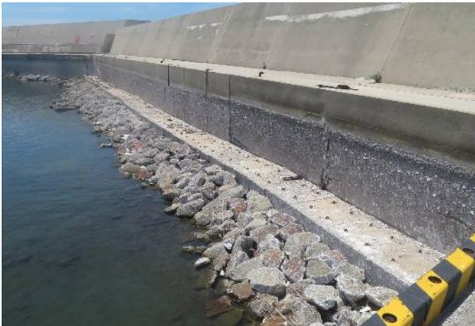
鹿磯漁港の防波堤です。激しい隆起の為に、防波堤のコンクリートは、最下部まで露出し、さらに港の底にあった碎石まで陸化しています。
