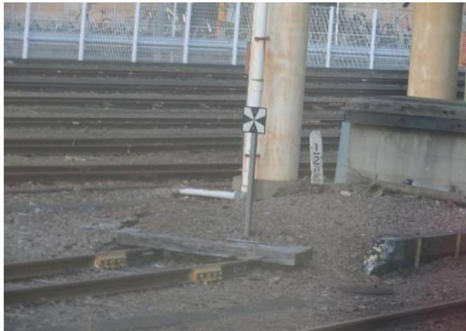
さまざまな系統の列車が行きかう立川駅なので、線路の本数も大変なもので、その中には「行き止まり」の線路も多数あります。線路の行き止まりには「車止め」と呼ばれる設備があります。写真のように単にバラスト(砂利)を盛っただけの簡素なものから、圧力ばね付の高性能のもの(たとえば、東武東上線池袋駅)
