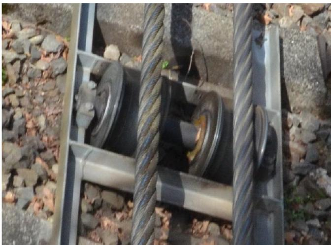
今回乗った車両は30分に1本だったので、車内は結構混んでいた。混んでいれば車両総重量が上がり、急傾斜の線路で鋼索が浮くはずだ。それをもう一度確認したかった。急傾斜の地点では、下の滑車が止まっていて、確かに鋼索は路面から浮いていることを確認できた。だからどうということはないのだが・・・。
