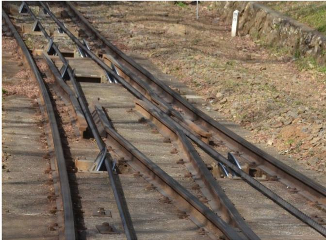
すれ違いの為の分岐器をすぎると、ケーブルを動かす鋼索は2本になる。左側が自分が載っている上り(運行上は下り)の車両をひっぱり上げる鋼索、右側がもう片方の下り(運行上は上り)の車両が落ちこまないように支える鋼索だ。当然逆に動いている。
