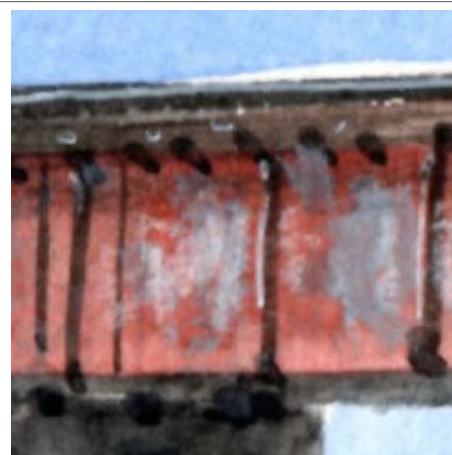
3、古いガーター橋は 少し塗装が剥がれた感じを出すのが難しいです
