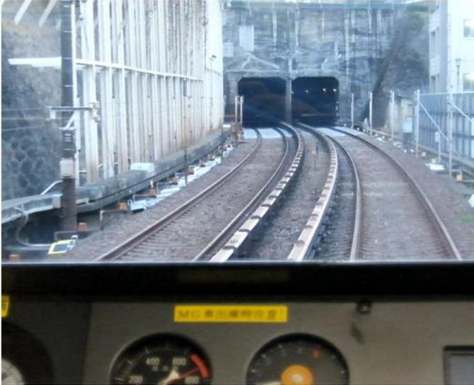
③この崖(写真では左側)は、武蔵野台地(小石川舌状台地)と神田川低地の境目の段差(段丘崖)である。丸ノ内線はその中腹付近に法面を造って、線路を敷いている。
