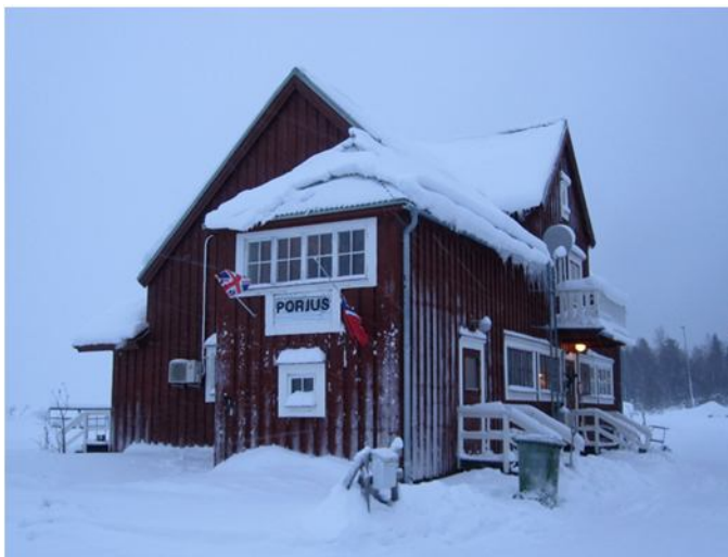
「オーロラカメラが設置されているポルユス駅舎」
