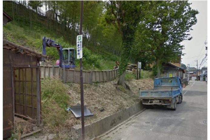
③の崖下。土止め工事を行っているようだ。一般に段丘崖は浸食されやすい。特に上部の砂礫層は、続成作用(土砂が岩石化する過程)が進んでいないので、土砂崩れを起こしやすいのだ。日常的に「段丘崖の補修」が必要なのだろう。
