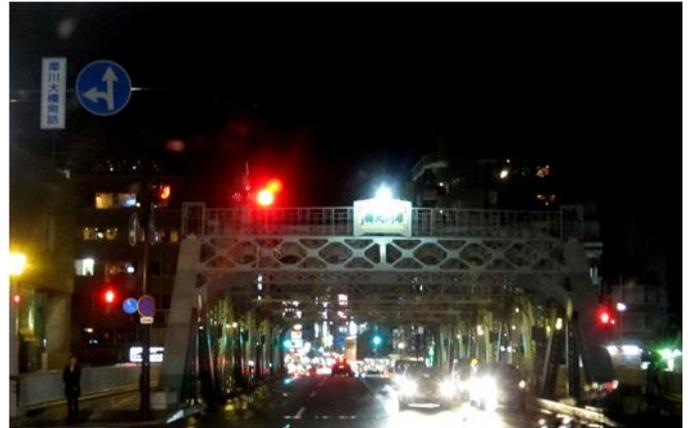
写真は「犀川大橋」を南側から見たところである。渡った先が「香林坊」である。隅田川の永代橋に似ている。梁の形状から、路面電車の架線があったのではないかと推理した。調べてみると、やはり、昭和 42 年まで路面電車が走っていた。
